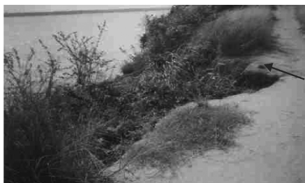
a) Erosion hydrique et ensablement du lac Ahémé sur la piste Hountoun
